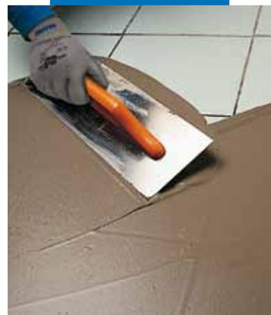
Rasatura di pavimento esistente con Nivorapid
